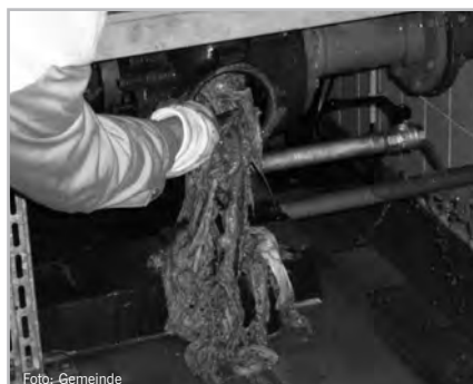
Die Feuchttücher lösen sich schlecht im Wasser auf. Wenn sie sich verknoten, können sie an den Pumpen hängenbleiben und diese blockieren.
