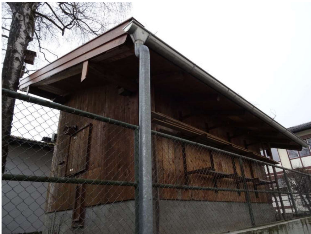
Abbildung 8: Potenzielle Versteckmöglichkeiten für Fledermäuse hinter den Windbrettern und der Holzverschalung des Schuppens östlich des Hauptgebäudes.
