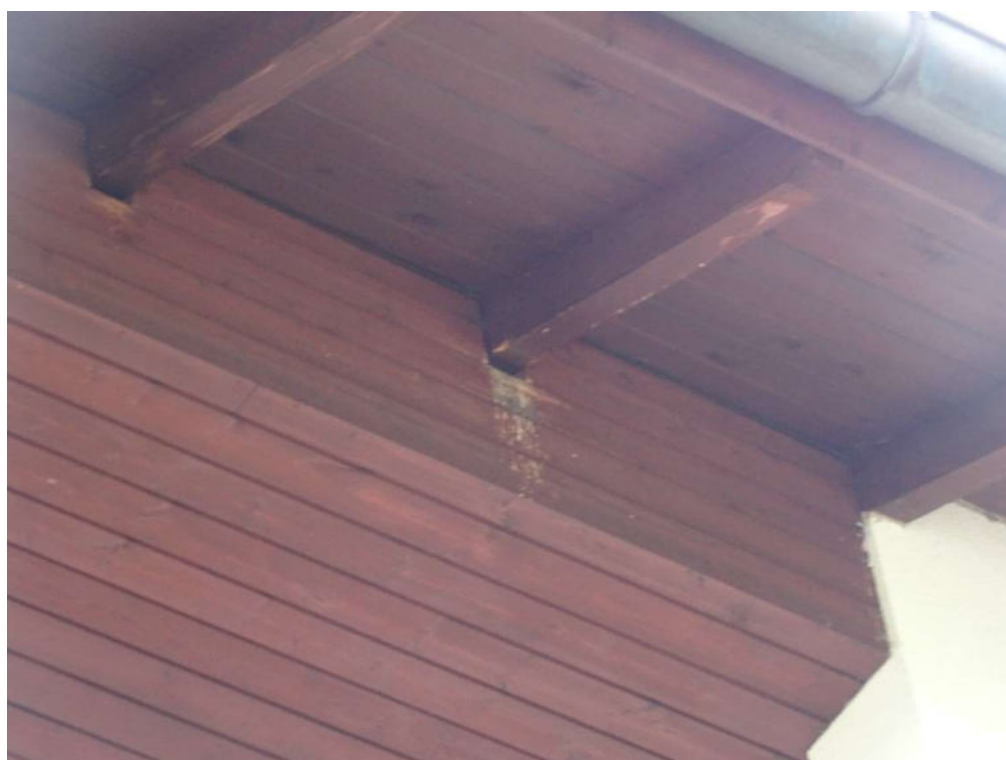
Abbildung 6: Kots Spuren gebäudebewohnender Vögel an der Holzverschalung über einem Balkon auf der Südseite des Hauptgebäudes.
