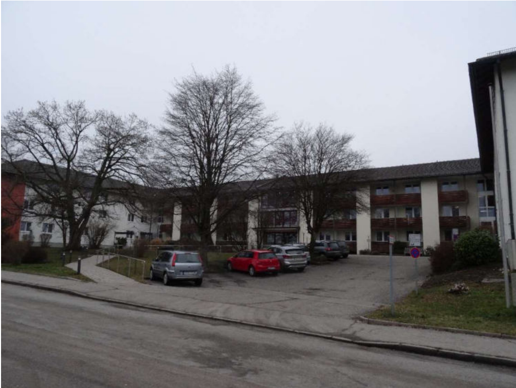
Abbildung 3: Blick von Süden auf das Hauptgebäude des Seniorenheims.
