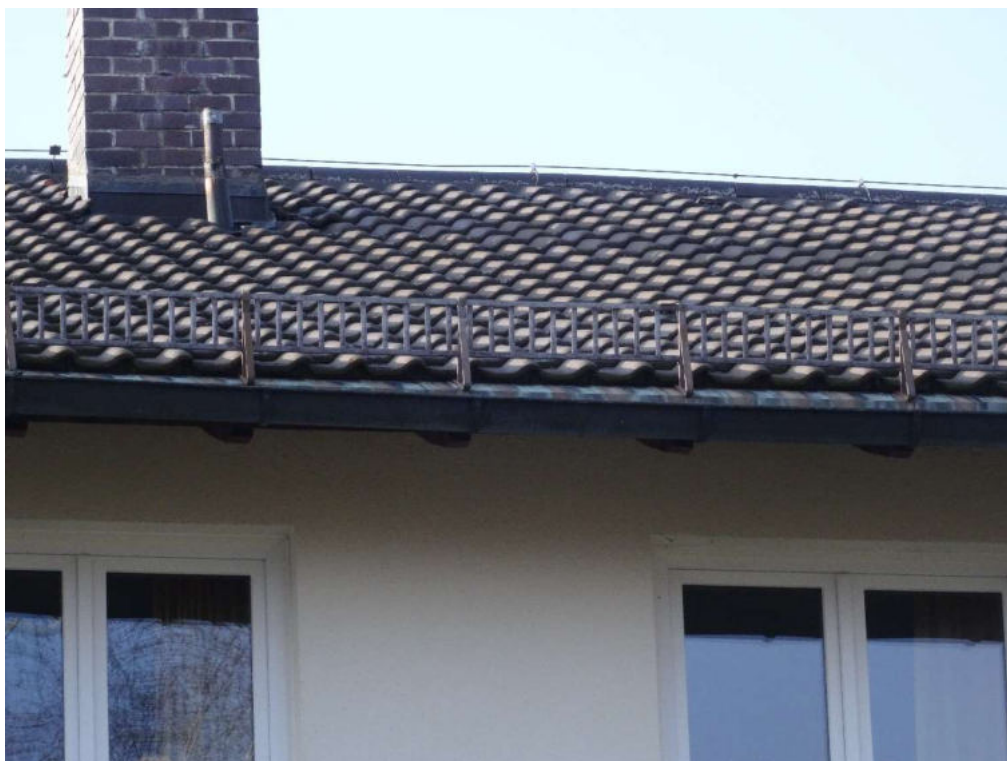
Abbildung 7: Potenzielle Einflugmöglichkeiten für Fledermäuse am Kaminsockel und unter den Ziegeln über der Dachrinne des Hauptgebäudes.
