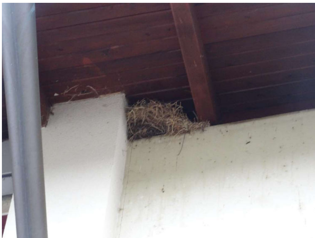
Abbildung 5: Sperlingsnest im Dachbereich rechts neben dem Eingang des Hauptgebäudes.
