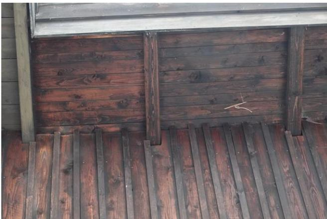
**Abb. 8:** Die hölzerne Außenverkleidung weist keine Spalten oder Einflugmöglichkeiten in Gebäudeinnere auf.
