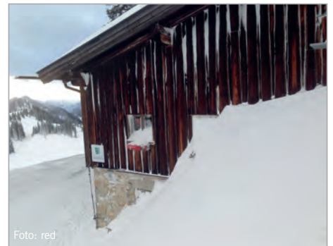
Mit unermüdlichem Einsatz schaufelten die Mannen der Sachranger-Aschauer Bergwacht sowie des Alpenvereins Sektion Prien das Dach frei.
