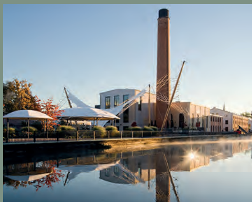
Mangfallkanal mit Turbinenhaus und Seilnetz
